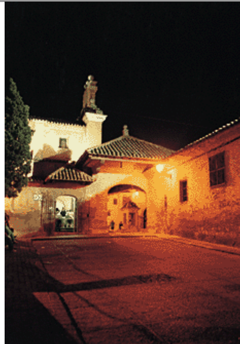
Acceso a "Los Silos" y Ermita de Sant Roc
